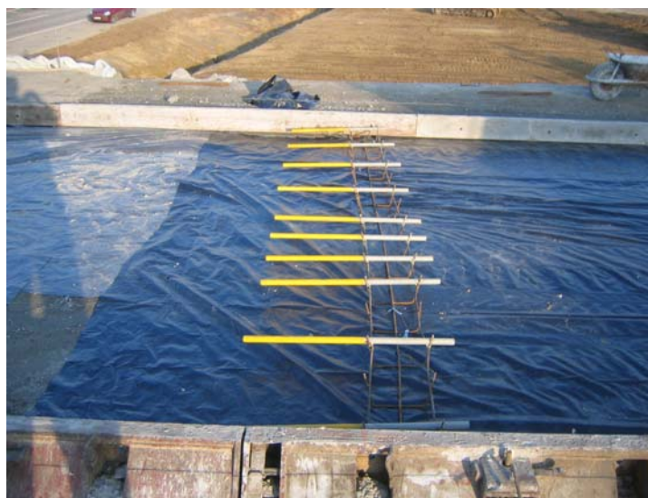
Hídfőre támaszkodó vasaltbeton pálya tábla 3
