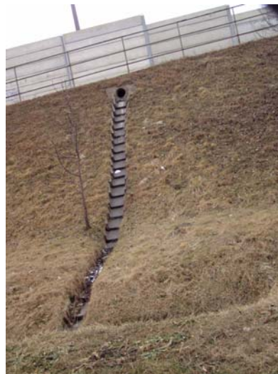
Víz kivezetése surrantóra, M0 útgűrű
