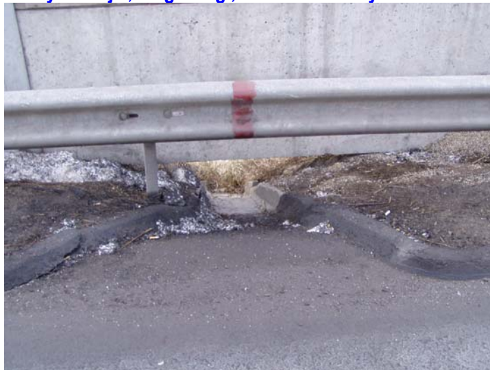
Víz kivezetése akna nélkül M3 autópályá
