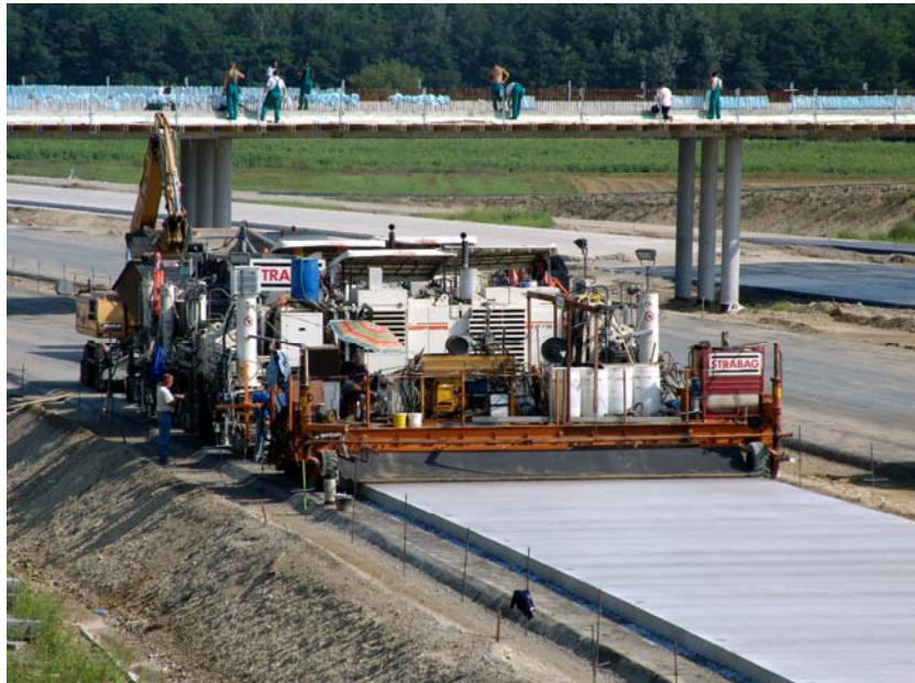
Kollektorpálya betonozása az M0 29-42 km szakaszán 2005. nyarán
