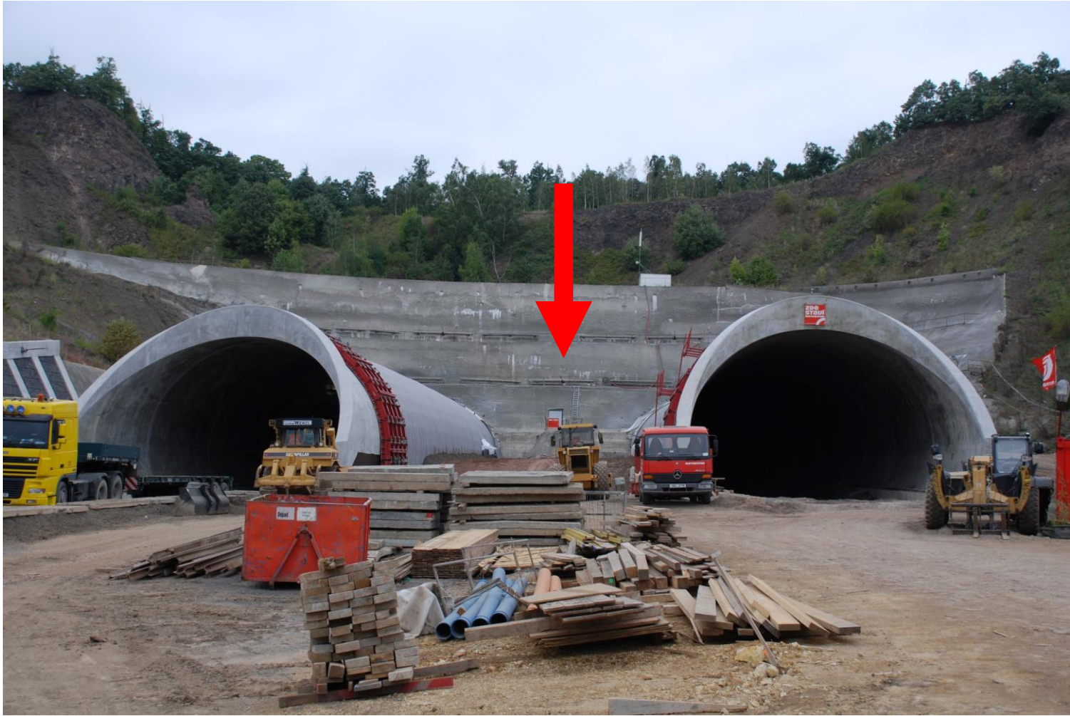
Prackovice tunnel D8 (Prague – Dresden) 260 m (R), 270 m (L) (2016)
