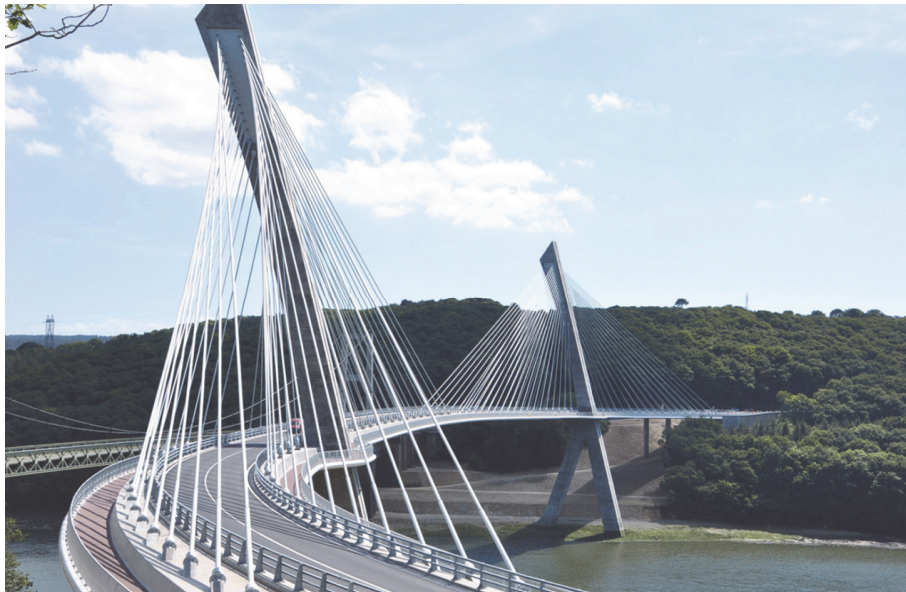
Fig. 21. The Térénez Bridge
