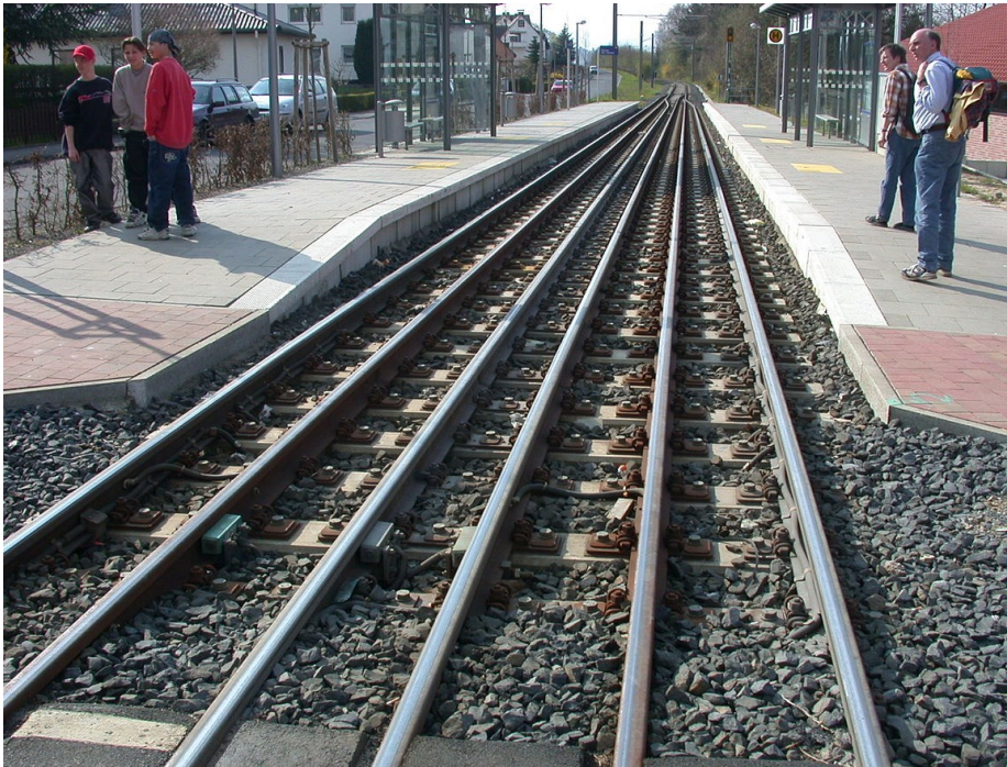
Vágányfonódással kialakított utasperon (Kassel, Németország)
