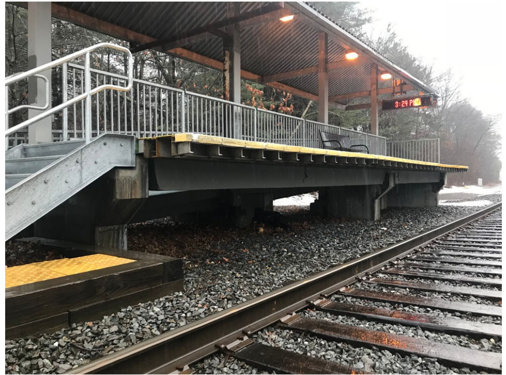
Felhajtható szélű peron (West Natic, USA)
