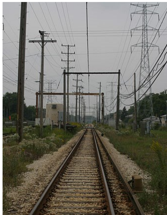
Felsővezeték és harmadik sín (átmeneti állapot) (Chicago, USA)
