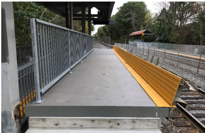
Felhajtható szélű peron (West Natic, USA)
