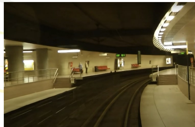
Eltolt peronkialakítás (Stuttgart, Németország)
