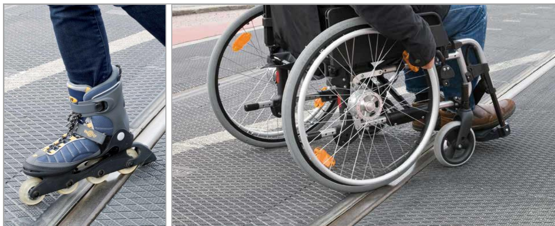
5–6. ábra: Sínvályú nélkül kialakított vasúti átjáró, amely alkalmas a kis kerekű „járművek” akadálymentes áthaladására (Forrás: www.strail.de )
