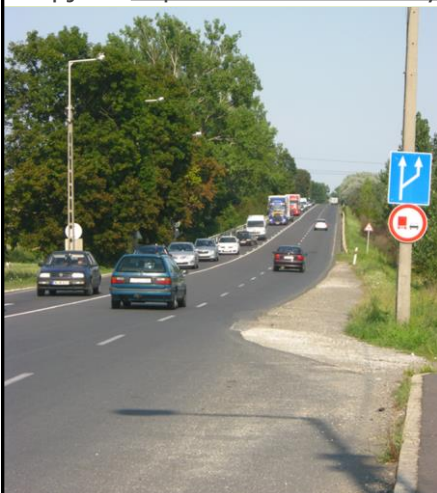
RQ15,5-ös mintakeresztmetszvény , fizikai elválasztás nélkül (Németország)
