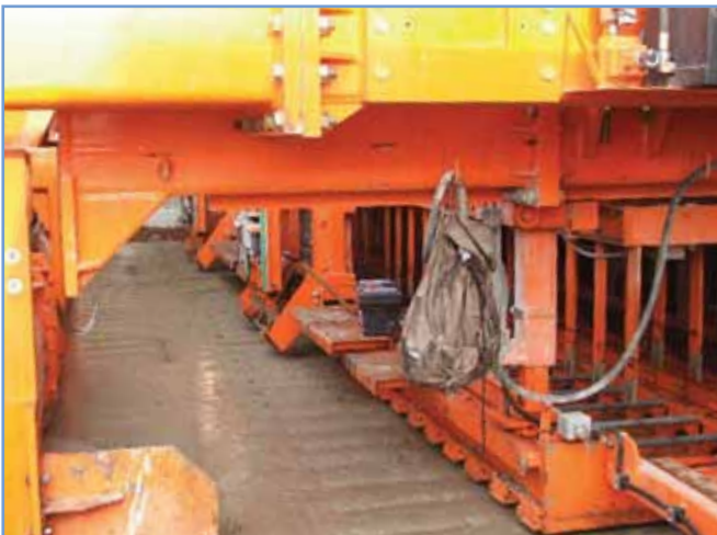
10. ábra: A kereszt- és hosszhézagvasak automatikus elhelyező berendezése
