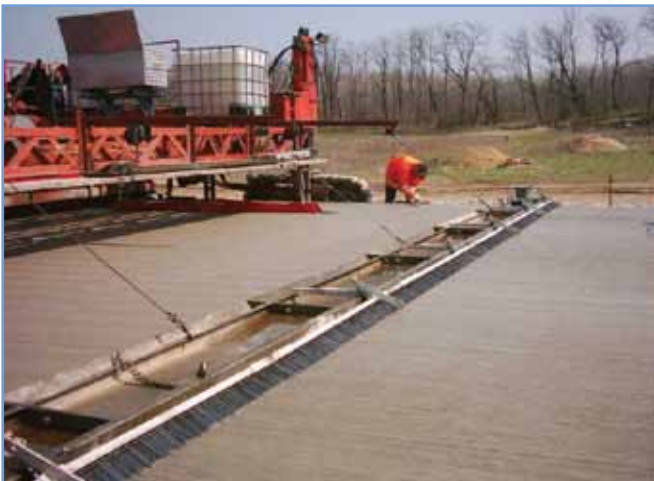
14. ábra: Felületképzés acélszerűvel
