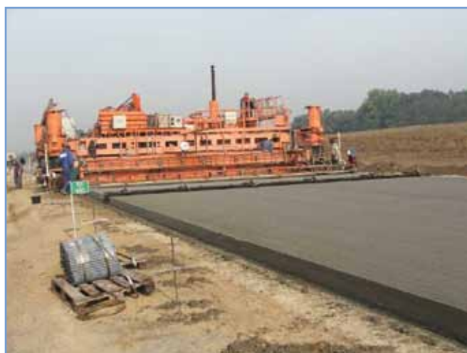
12. ábra: A főpálya építése
