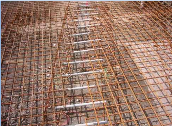
13. ábra: Betonacélháló kereszthézagvasakkal a hézagokban
