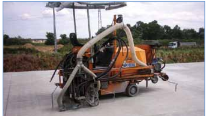
15. ábra: Hézagvágó vágóiszap-felszívó berendezéssel
