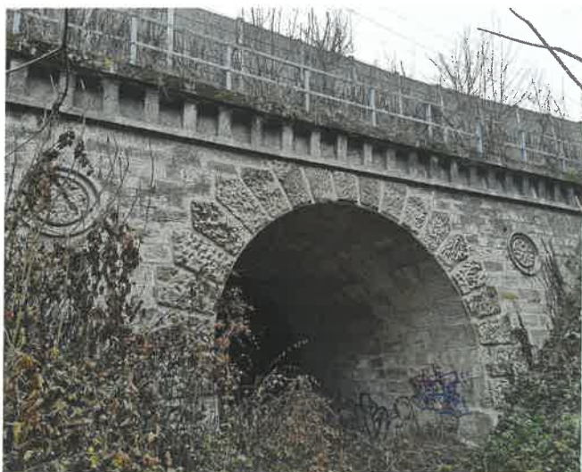
1. ábra. Vasúti kőboltozat az 1861-ben átadott 30. számú vasútvonalon
