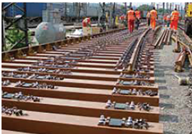
1. ábra. Kitérő építése FFU-aljakkal
